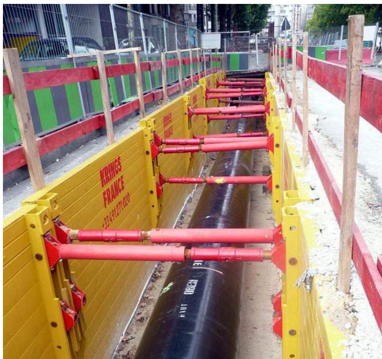
Slika 8. Krings KS100 tipska podgrada za razupiranje rova (primjer)
